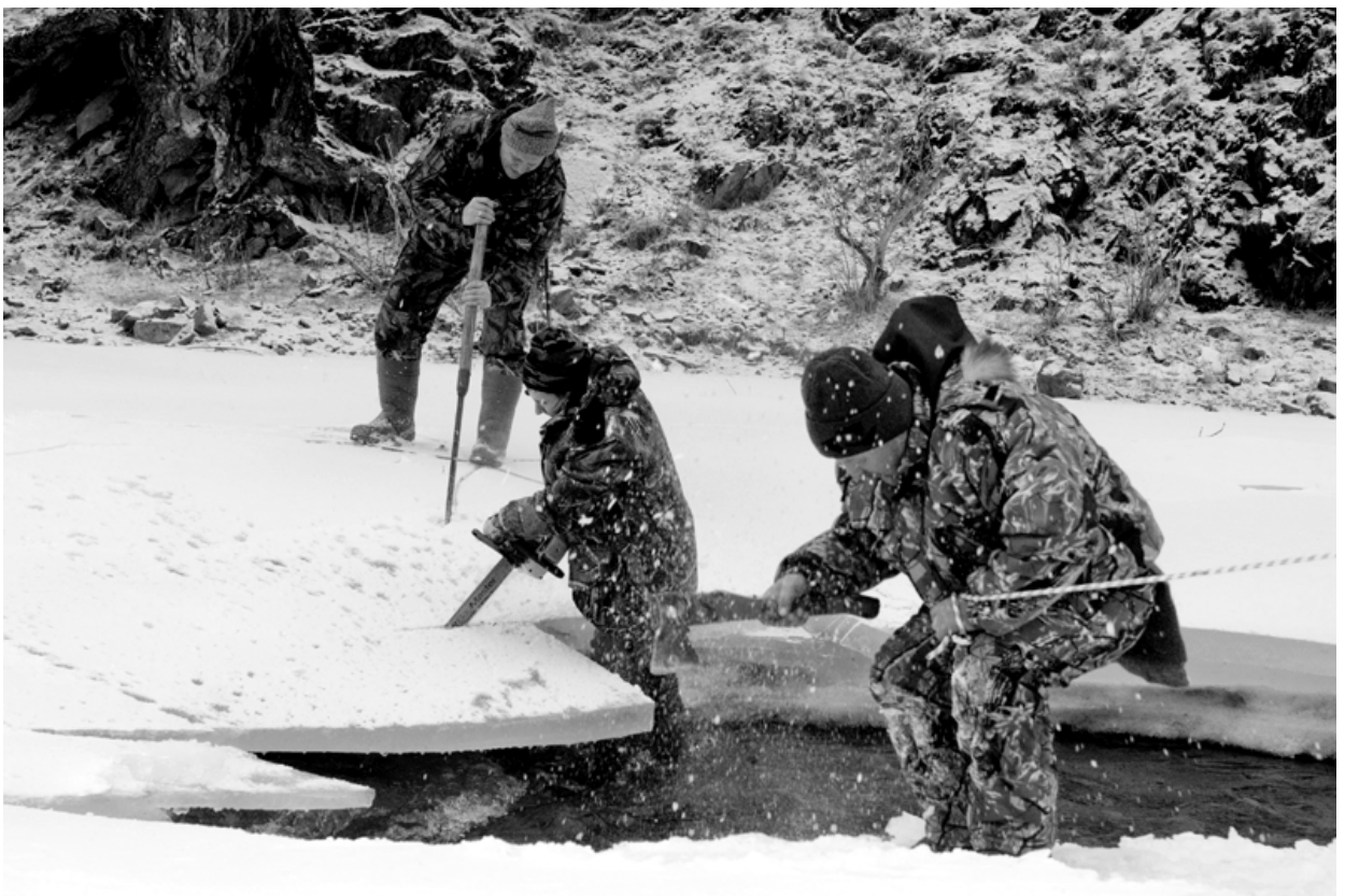
Рис. 18. Подготовка автомобильного брода через горную реку.
